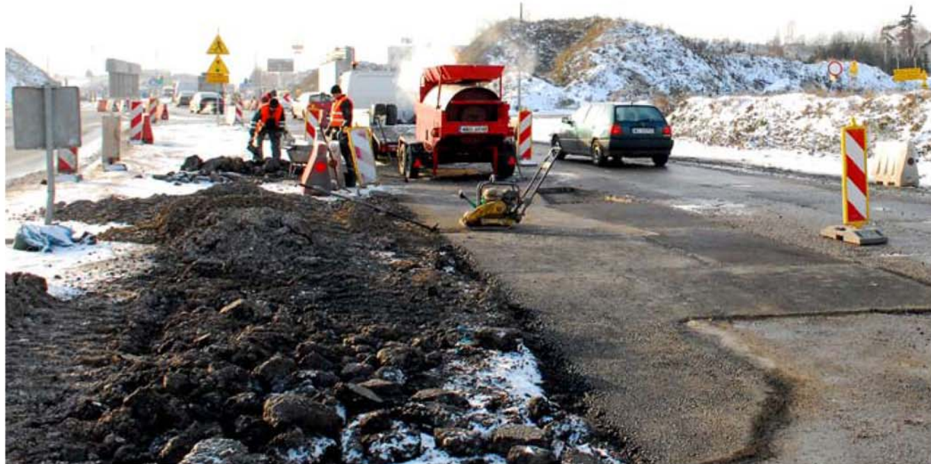
Pierwsza łopata pod budowę kompleksowego węzła Łopuszańska (łączącego Al. Jerozolimskie z ulicami Łopuszańska i Kleszczową) została wbita ponad trzy lata temu
