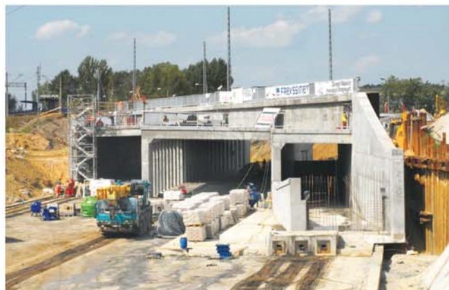
Najpierw wybudowano tunel, a następnie rozebrany został nasyp i wsunięto w niego gotową konstrukcję
