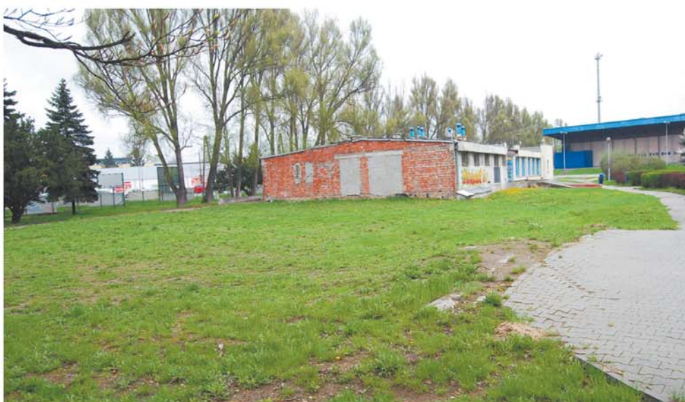
Najważniejszą inwestycją w tegorocznym budżecie miasta pozostaje Centrum Dziedzictwa Kulturowego na terenie MZOS Znicz przy ul. Bohaterów Warszawy, którego budowa ruszy jeszcze w tym roku
