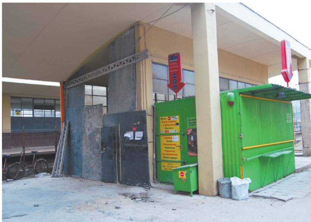
Długo oczekiwany remont przejścia podziemnego, zgodnie z umową, musi zakończyć się w trzecim kwartale tego roku
