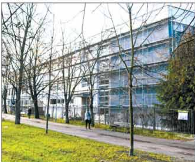
Trwa budowa nowego skrzydła szkoły przy ul. Konińskiej
