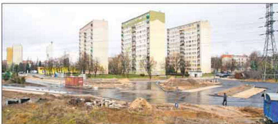
Rozbudowa ul. Orłąt Lwowskich – znajdzie się tu nowa pętla autobusowa
