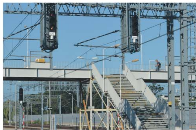
Już niebawem ruszą prace związane z kapitalnym remontem kładki
