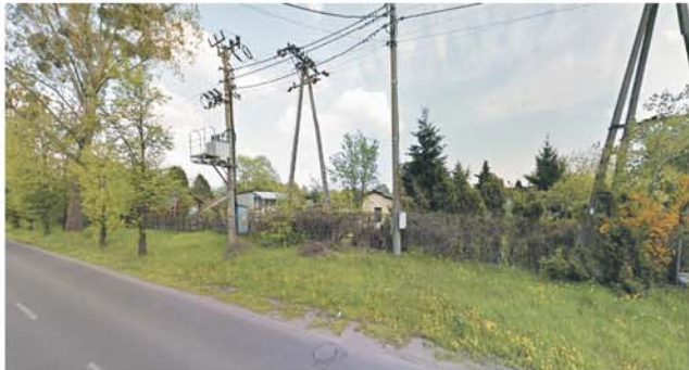
Od wielu lat działkowicze Rodziny Ogródów Działkowych im. Jana Szyllera w Brwinowie, wraz z Zarządem działek, walczą o utworzenie przejścia dla pieszych na ulicy Powstańców Warszawy w rejonie skrzyżowania z ul. Żółwią. Fot.: Internet (satelita Google)
