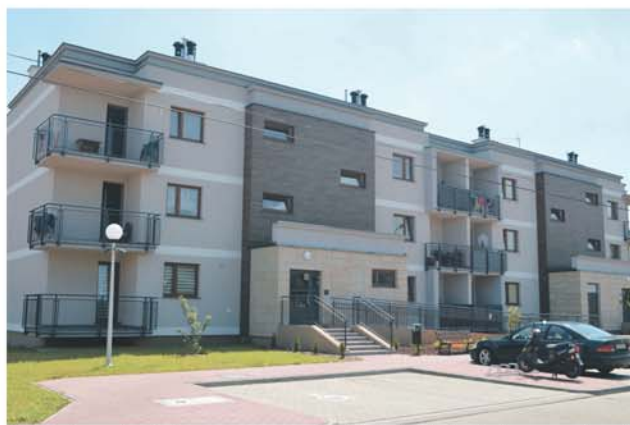
W oddanych niedawno do użytku dwóch blokach komunalnych przy ul. Studziennej znajduje się łącznie 48 mieszkań. Miasto planuje budowę kolejnych pięciu, w których znajdzie się w sumie 105 mieszkań
